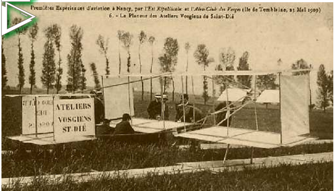
Photo du haut : L'assemblage du planeur se termine aux dernières maisons de Tomblaine. C'est en aval de la centrale électrique, le bâtiment qu'on voit entre deux arbres, le terrain d'essai est au-delà, le bras retournant à la Meurthe est en contrebas à droite. Photo du bas : Sur "l'île", le planeur est tourné face au Sud sur des plaques pour améliorer le glissement. On s'affaire aux derniers préparatifs. On voit nettement un empennage biplan-bidérive cellulaire à l'arrière, et un plan de profondeur mobile à l'avant. Rien n'indique une autre commande.
